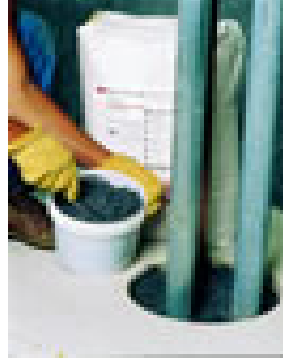
Resim 1.25: Yangına dayanıklı harç
