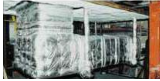
Resim 2.4: Malzemeyi giydirme yöntemi ile montaj
