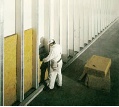
Resim 2.5: Malzemeyi kaplama yöntemi ile montaj
