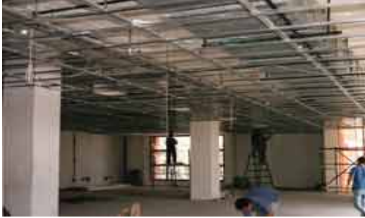
Resim 2.6: Asma tavan metal iskelet montajı
