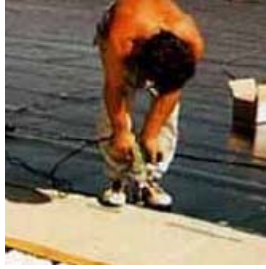
Resim 2.1: Malzemeyi serme-döşeme ile montaj
