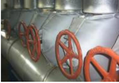
Resim 2.4: Malzemeyi giydirme yöntemi ile montaj
