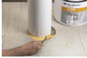
Resim 1.28: Yangına dayanıklı silikon
